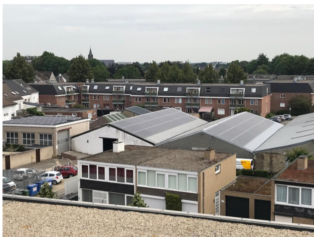
Overzicht 348 PV panelen daken Linde 6, het eerste project
